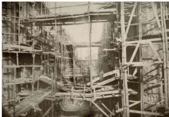
Ponteggi per la costruzione degli edifici della Galleria Vittorio Emanuele II Fotografo non identificato, 1866 (Milano, Archivio Storico Civico e Biblioteca Trivulziana, Cartografica 11/18)
