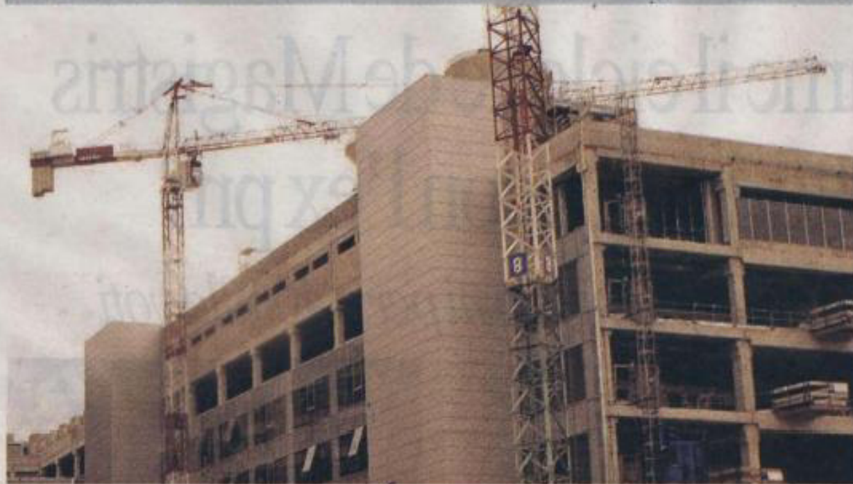
GRATTACIELI Cantieri a Milano per favorire gli imprenditori del cemento vicini al centrodestra
