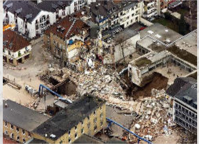
2009 Crollo dell'edificio ospitante l'Archivio storico di Colonia
